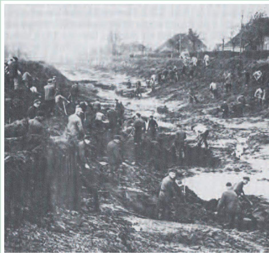
Arbeiter bewegen sich beim Bau des Kanals in einem „Meer aus Sumpf und Morast“, hier nahe Marcardsmoor. Der Aushub wird auf beiden Seiten und in einiger Entfernung zum Kanalbett abgelagert. Es entstand ein Damm, der heute noch erkennbar ist.
