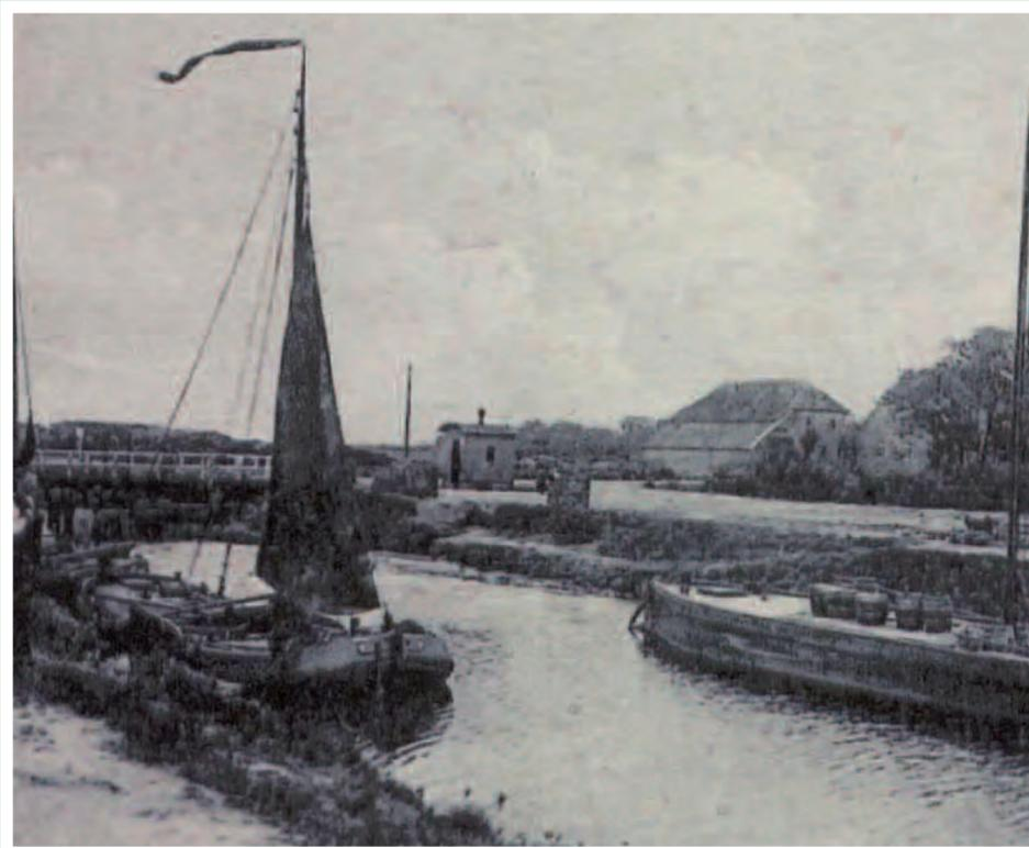
Segel- und Treidelschiffe auf dem noch jungen Ems-Jade-Kanal. Die Schleppeinen wurden mittig am Mast befestigt. Abb.: um 1910.
